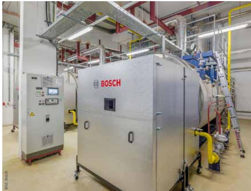
Der modernisierte Schaltschrank mit der Bosch-Kesselsteuerung „BC0“ (Boiler Control) sowie die neuen Schalldämmhauben für die Brenner ergänzen unter anderem die bestehende Dampfkesselanlage bei Octapharma.
