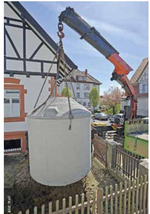
Lieferung eines Regenspeichers aus Beton zum nachträglichen Einbau bei Modernisierung und Renovierung. Ein Versetzen vom Lkw des Herstellers direkt in die vorbereitete Baugrube (15 – 20 cm Sandbett) ist möglich.
