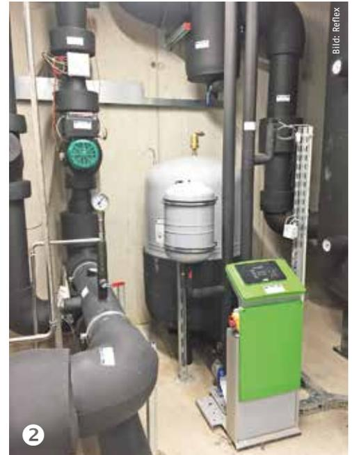
Zum Funktionieren der Anlage tragen auch die Schmutzabscheider „Exdirt“ bei – zusätzlich ausgestattet mit den Hochleistungsmagneten „Exferro“. Sie entfernen ferromagnetische Partikel wie Magnetit aus dem Anlagenwasser.
