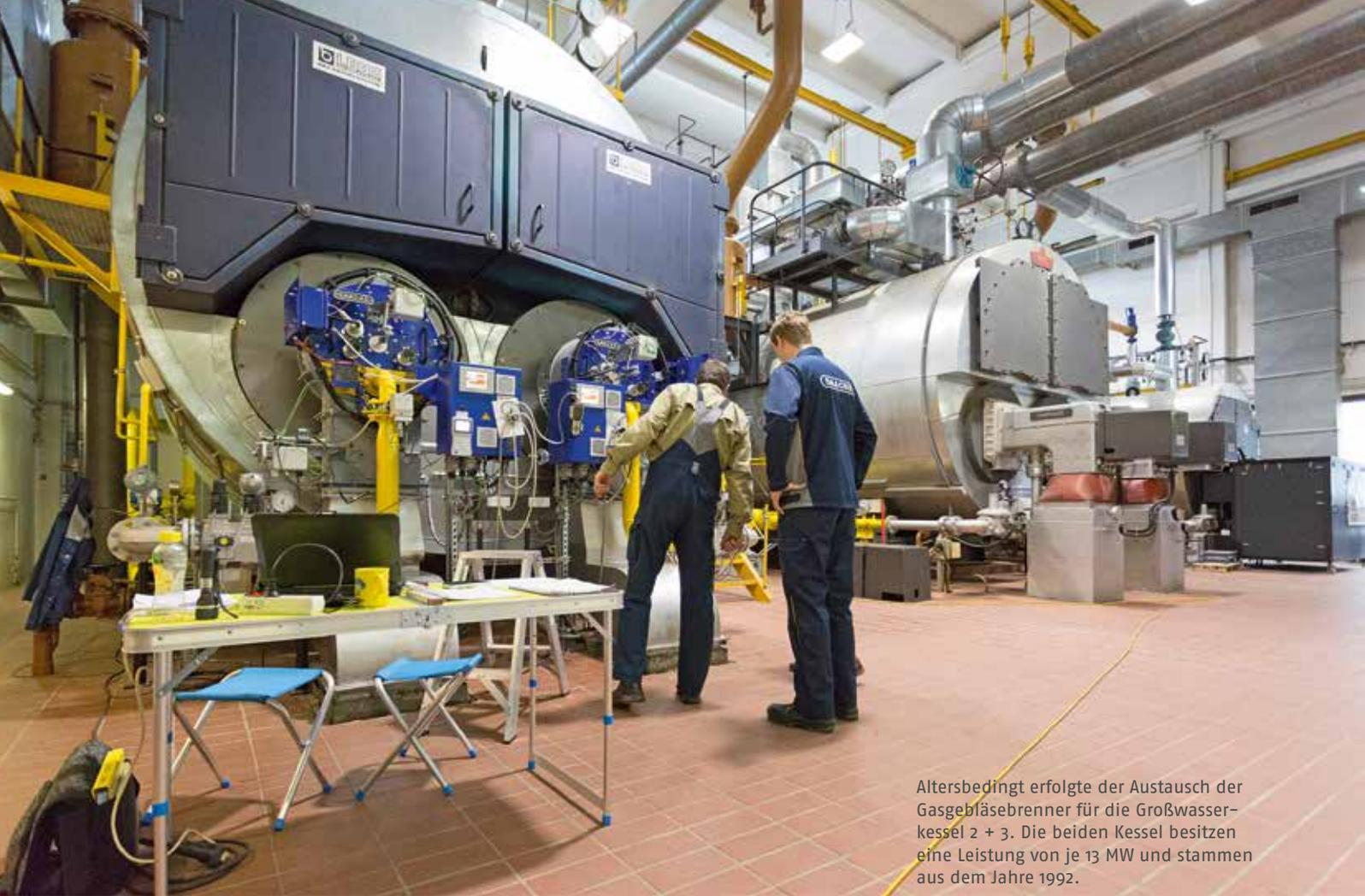
Altersbedingt erfolgte der Austausch der Gasgebläsebrenner für die Großwasserkessel 2 + 3. Die beiden Kessel besitzen eine Leistung von je 13 MW und stammen aus dem Jahre 1992.
