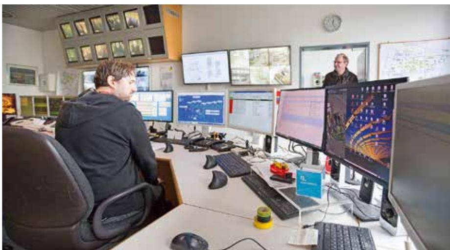
Eine umfassende Gebäudeautomation steuert und regelt alle größeren Verbraucher der Gebäudetechnik. Die technische Leitwarte ist rund um die Uhr besetzt, zudem werden Verbrauchs- und Leistungswerte permanent automatisch erfasst und kontrolliert.
