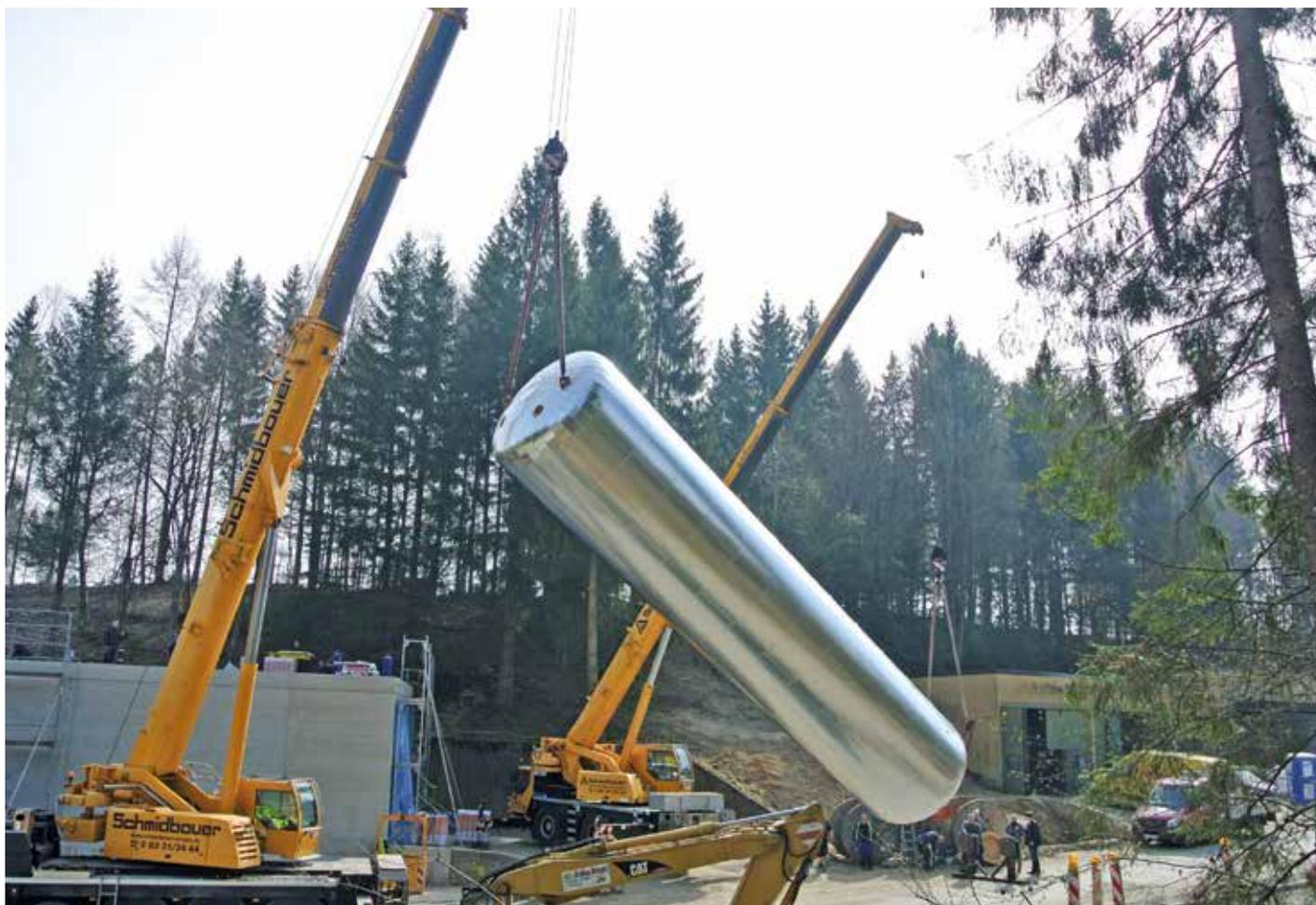
Aufstellung des Pufferspeichers. Zwei Kräne bringen den 16 m hohen und 12 t schweren Behälter in Position. Viel Platz für Wärme auf Vorrat: Sein Speichervolumen liegt bei 100 m<sup>3</sup>.
