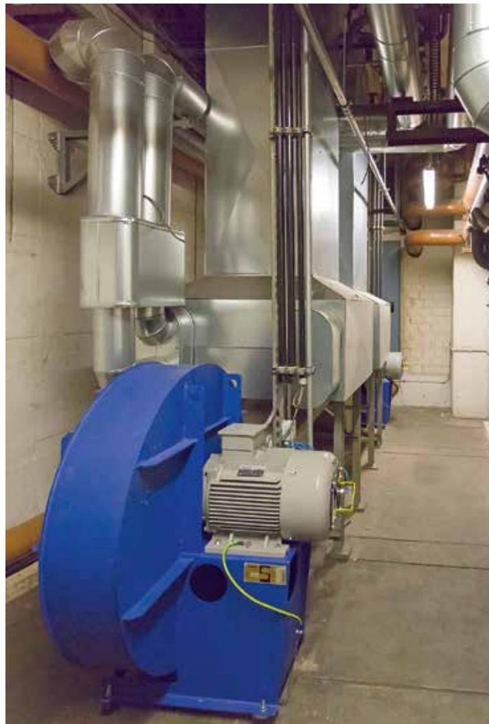
Im Zuge der Modernisierung wurde auch die Verbrennungsluftversorgung angepasst. Vorgewärmt auf rund 70°C gelangt sie über Kanäle aus dem Untergeschoss der Heizzentrale direkt zu den Brennern.
