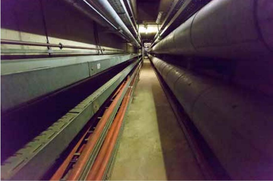
Strom, Wärme und Kälte werden auf den Campusteilen Nord und Süd zentral verteilt, unter anderem durch ca. vier Kilometer lange unterirdische Versorgungskanäle.
