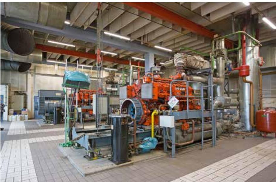
25 Mio. kWh Strom werden für die Versorgung der angeschlossenen insgesamt rund 100 Gebäude benötigt. Einen großen Teil davon produziert die Uni über BHKWs. Die installierte und inzwischen in die Jahre gekommene Kaskade hat eine Leistung von 2 MW<sub>el</sub> und 3,6 MW<sub>th</sub>.
