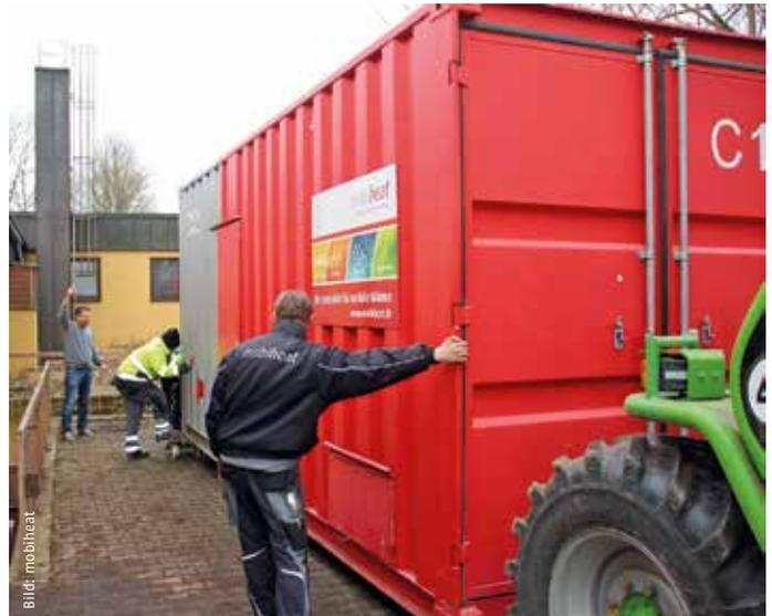
Autark und fernüberwacht: die mobile Heizanlage von mobiheat, bestehend aus Heizzentrale mit 1 MW Leistung und doppelwandigem Heizöltank (4800 l). Der Heizcontainer, angeliefert mit dem mobiheat-eigenen Lkw mit Kran, übernahm vorübergehend die Beheizung des Hallenbades Almarin in Mönchsdeggingen (westlich von Ingolstadt).
